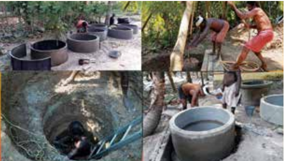
മാനവീയം ഇലിപ്പുകുളം ഭരണിക്കാവ് പഞ്ചായത്തിൽ ലോക്ക് ഡൗൺ കാലത്ത് നിർമ്മിക്കുന്ന കിണറുകളുടെ നിർമ്മാണം
